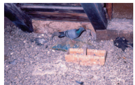
Abbildung 3: Auf Dachböden die jahrelang von Straßentauben besiedelt wurden leben meistens verschiedenen Arten von Ektoparasiten, die in darunter liegende Räume einwandern und dort den Menschen und seine Haustiere befallen können.
